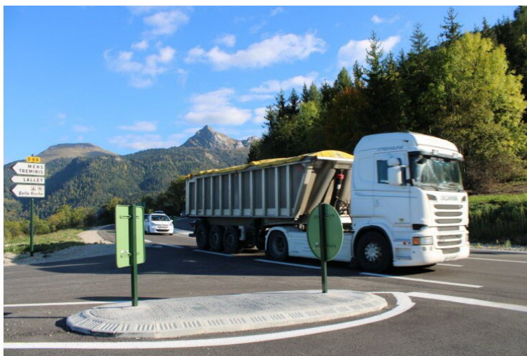
Parmi les travaux, à l'intersection des routes départementales 1075 et 66 en direction de Lalley et de Mens. Un carrefour équipé d'un tourne-à-gauche et d'un îlot directionnel, avec élargissement des deux RD a été aménagé. Photo Le DL/Jean Yves LE MENEZ
